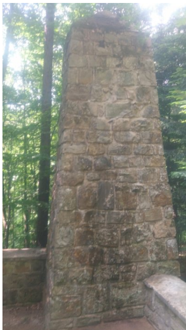
Prace przy cmentarzu wojennym nr 66 w Małastowie
