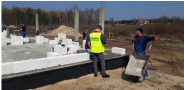
Nielegalna praca na budowie
