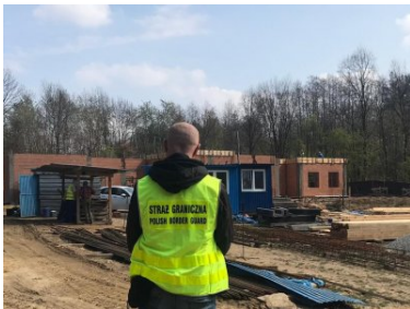
Nielegalna praca na budowie
