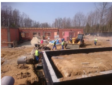
Nielegalna praca na budowie
