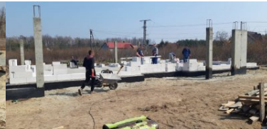
Nielegalna praca na budowie
