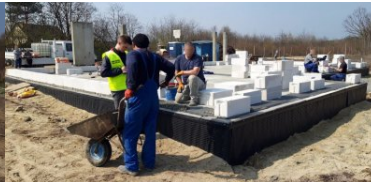
Nielegalna praca na budowie
