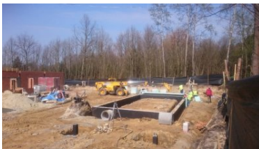
Nielegalna praca na budowie
