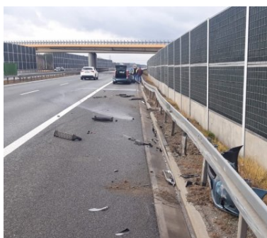
Zabezpieczyli miejsce wypadku
