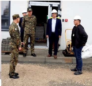
Skontrolowano przebieg realizacji budowy nowej Placówki SG w Tarnowie
